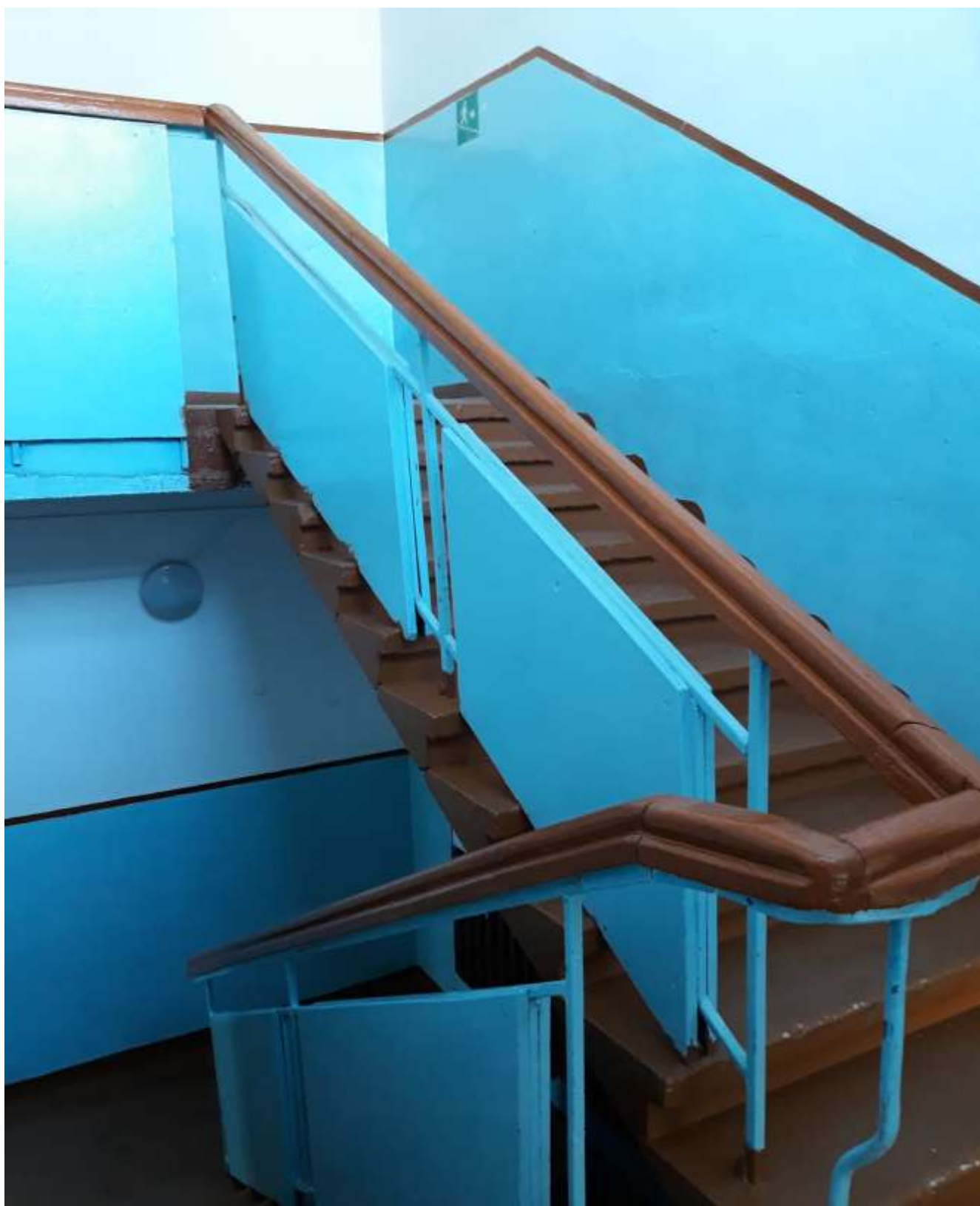
Фото № 7 Пути перемещения, лестница на 2 этаж
