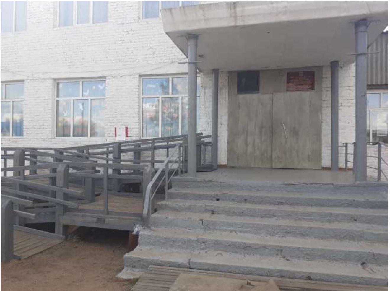
Фото № 2 Вход в здание
